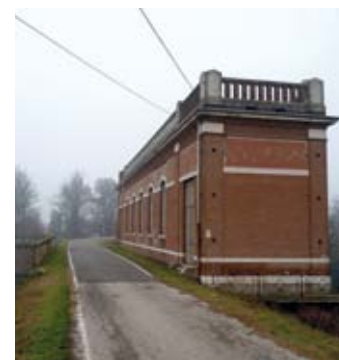
La controchiavica dell'impianto di San Siro Foto R. Vergnani
