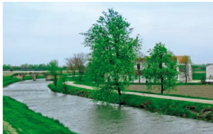
Canale Fossalta Inferiore e l'antico Ponte Vela
