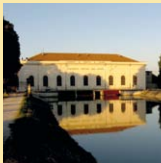
Impianto idroforo del Canale di Revere
