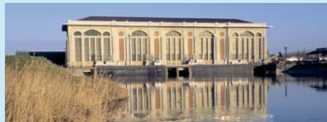
Impianto Idrovoro di scolo e derivazione Pilastresi. Foto archivio Consorzio Bonifica Burana
