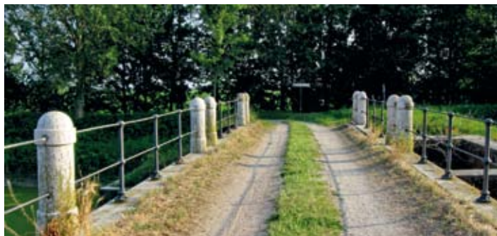
Passaggio sul ponte al km 9,4
