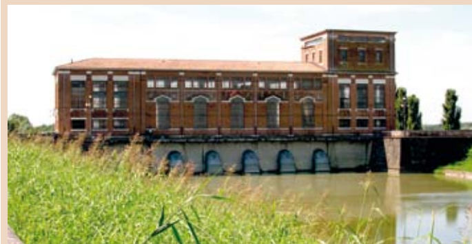
Impianto idrovoro di Mondine. Foto archivio Consorzio agrituristico mantovano
