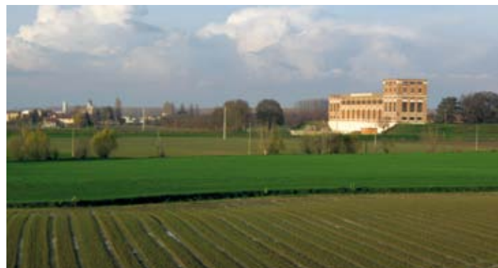
Impianto idrovoro di San Siro
