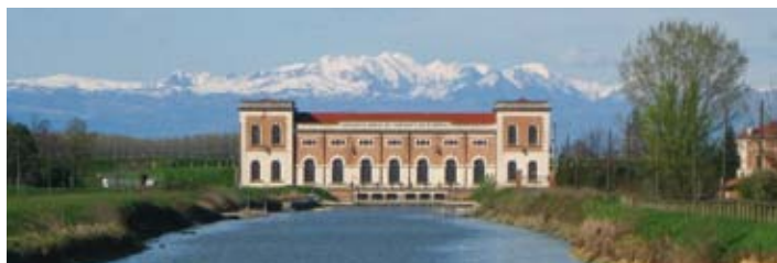
Impianto di bonifica della Travata
