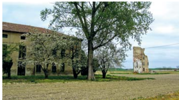
Corte agricola e torre colombaia a Zerbinato
