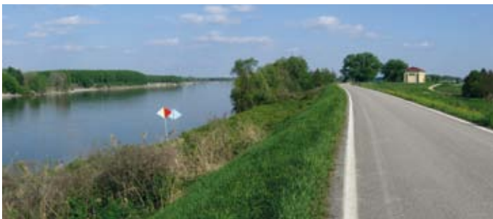
Impianto di bonifica del Sabbioncello nei pressi di Quingentole
